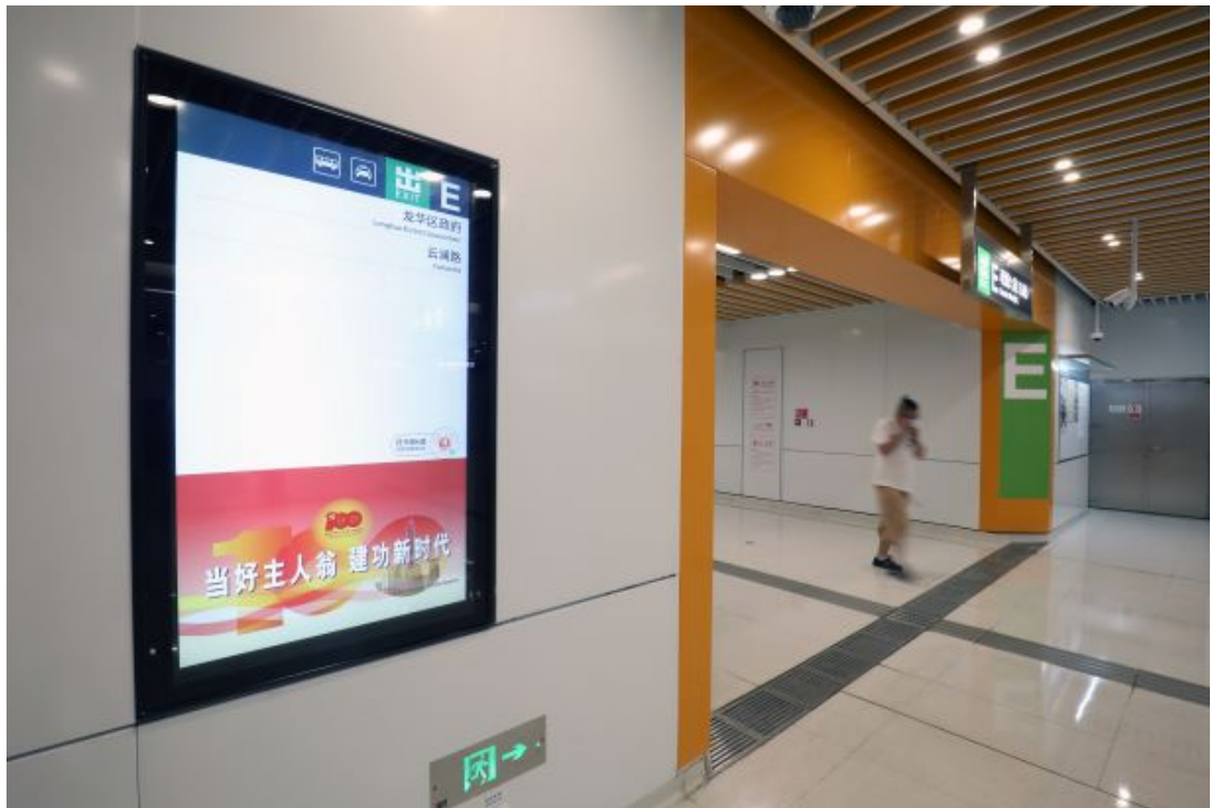
4 号线全线车站出入口导向牌升级为液晶显示电子导向屏
