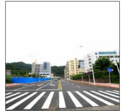
■ 梅坳二路完成道路恢复
